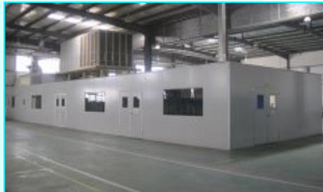
內飾件塗裝生產線
